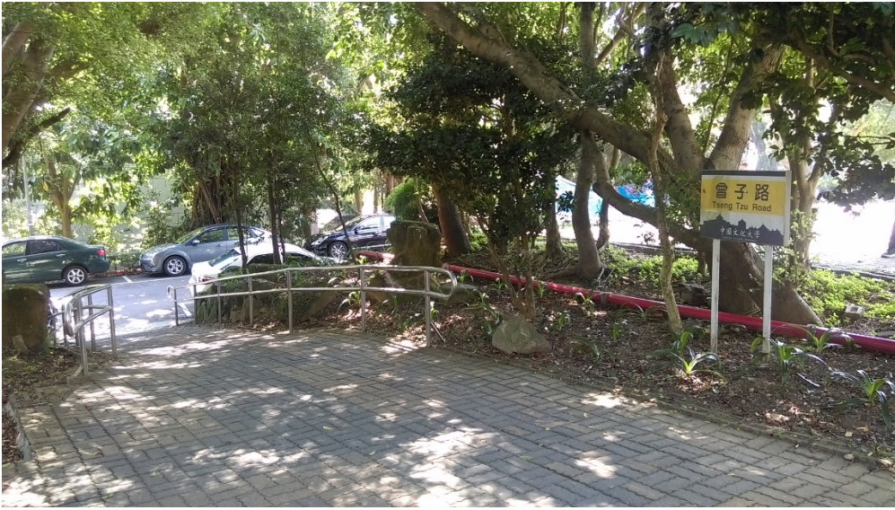
無障礙坡道扶手(百花池、大義館間)
