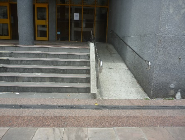
東側(臨曉峰館)坡道及扶手
